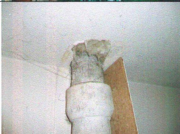
Am innen liegenden Entwässerungsrohr hat sich ebenfalls Schimmel gebildet. Vorsicht: dieses Rohr darf nicht mechanisch bearbeitet werden. Es ist ebenfalls aus Asbestzement. Solange keine Fasern frei gesetzt werden besteht auch kein weiterer Handlungsbedarf wegen dem Asbest.
