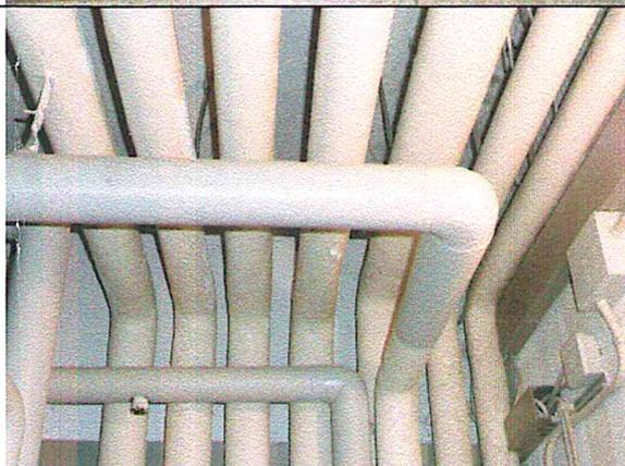
Die Gipswicklung auf der alten Rohrisolierung kann asbesthaltig sein. Vor evtl. Rückbauarbeiten empfehle ich Ihnen eine Überprüfung des Materials.
