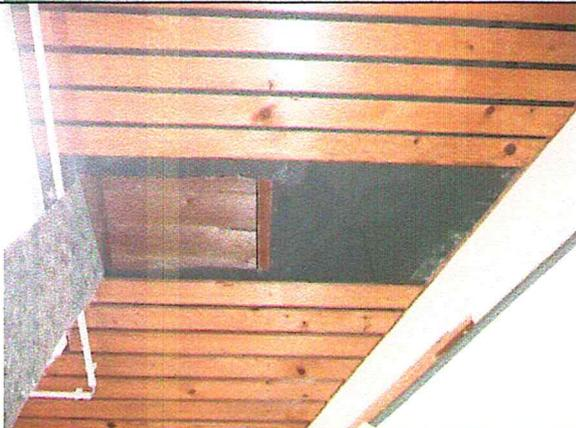
Im Gruppenraum 3 haben wir eine Bauteilöffnung vorgenommen. Es zeigten sich mit Holzschutzmitteln behandelte Sparren sowie Schalbretter. Die Laboranalyse hat die Einschätzung bestätigt. Es liegt eine extreme Belastung der Holzkonstruktion durch Holzschutzmittel vor.
