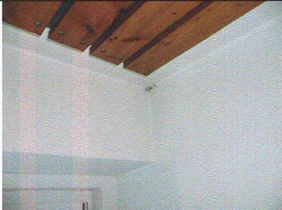
In der Küche gibt es Schimmel in der rechten oberen Außenecke. Auch dort zeigt sich das typische Schadensbild von Wärmebrücken und Kondensatfeuchte. Durch die hohe Luftfeuchte, die kalte Oberfläche und den nährstoffhaltigen Untergrund kommt es hier zur Schimmelbildung.
