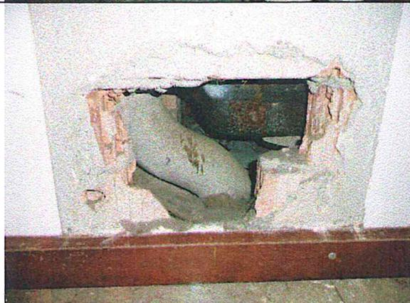
Auch dahinter befindet sich eine Wandöffnung. Das Abwasserrohr aus Asbestzement ist zu sehen. Von der Bauteilöffnung geht ein starker Abwassergeruch aus. Es liegt die Vermutung nahe, dass die Abwasserleitung einen Defekt hat. Bitte öffnen und prüfen ohne das Asbestzementrohr zu beschädigen.
