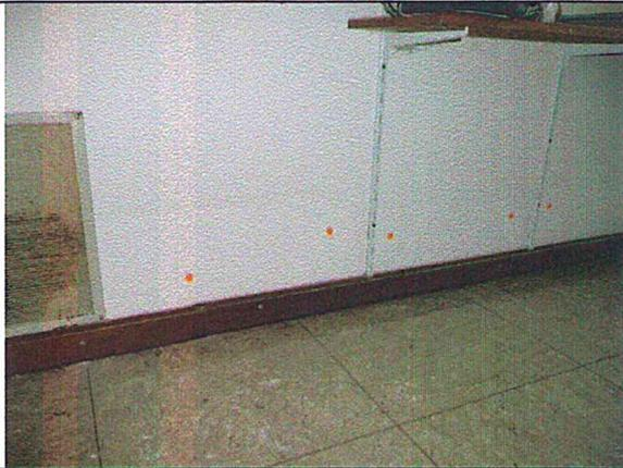
Die Trennwand zwischen Papierlager und WC- Waschraum hat im Sockelbereich erhöhte Feuchtwerte. Der Feuchteverlauf ist mit Punkten markiert. Auch dies ist ein Hinweis auf einen Defekt an der Installation.
