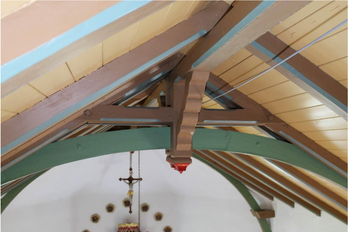
Bild 6: Knotenpunkt Firstbereich, Blickrichtung Osten.
