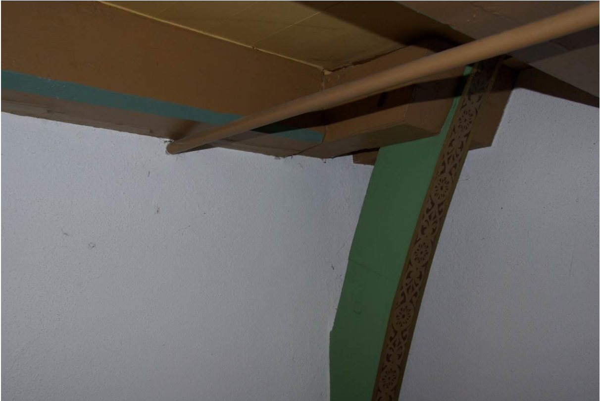
Bild 10: Zugelement neben der westlichen Bogenkonstruktion.
