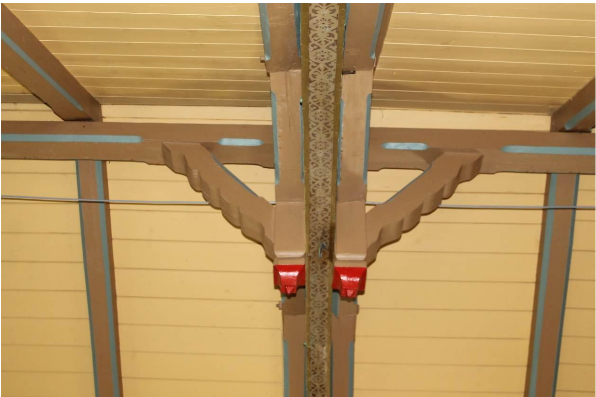
Bild 7: Knotenpunkt Firstbereich Bundachse.
