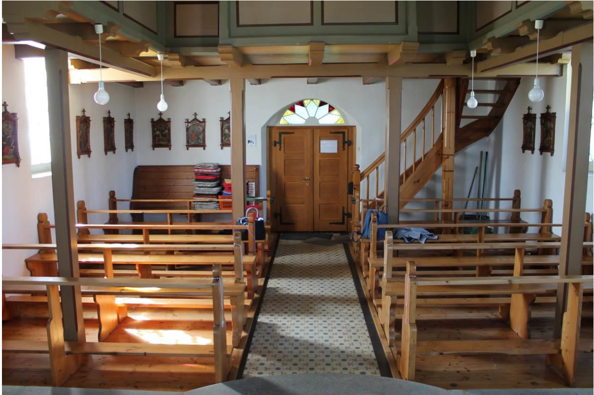
Bild 4: Erdgeschoss, Blickrichtung Westen.
