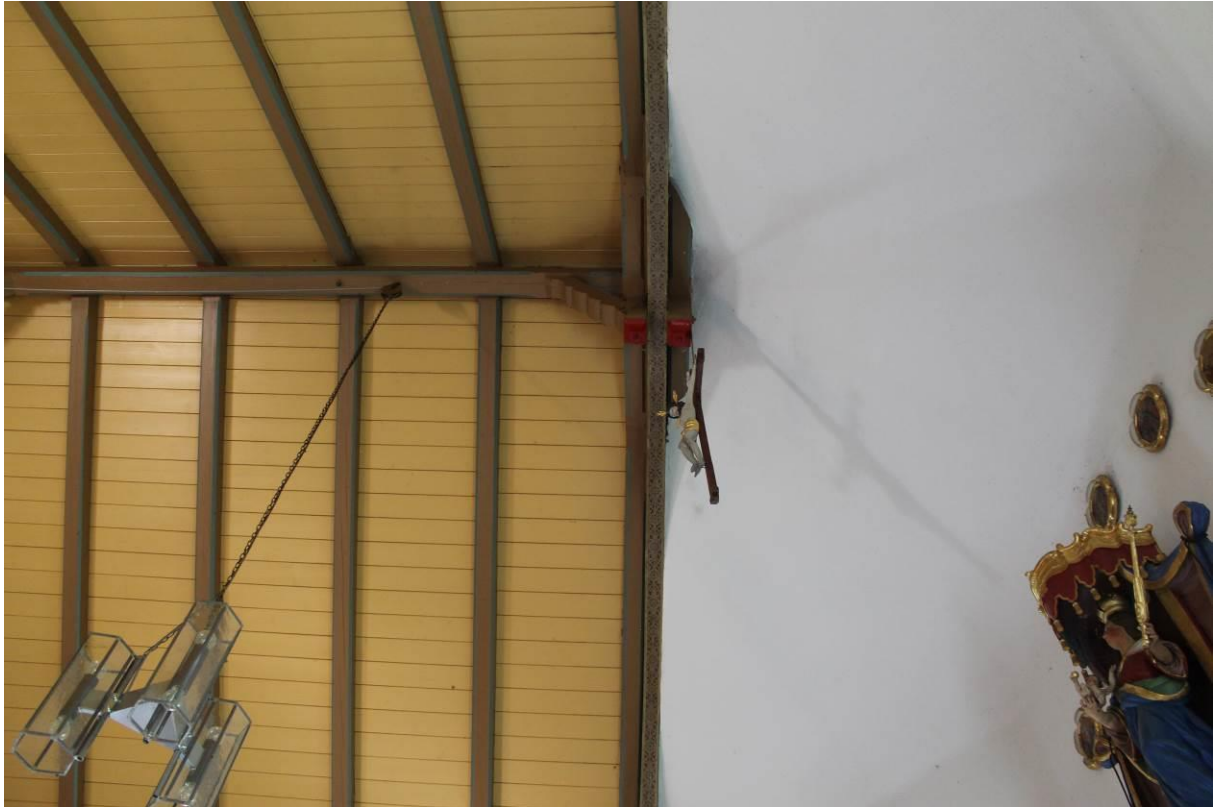
Bild 8: Übergang Satteldach / Altarraum.
